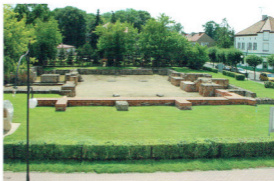
6 | Zrekonstruowane fundamenty fary
